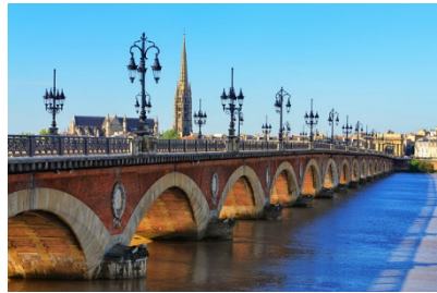
Le pont de pierre construit entre 1810 et 1822 – Inscrit aux Monuments Historiques
